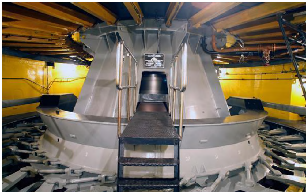
Рисунок 5.3 – Шахта гидротурбины
