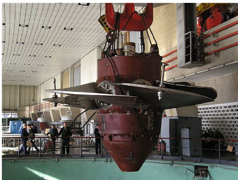
Рисунок 5.4 – Гидротурбина ПЛ30-В-930 на монтажной площадке завода-изготовителя
